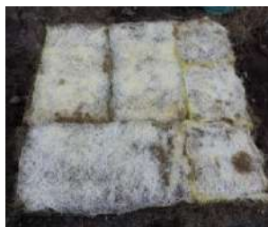
Рис. 19. Работы по укладке дернины завершены. Фото М. Слуковской
