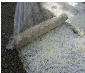
Рис. 18. Укладка дернины на озелняемом участке. Фото М. Слуковской
