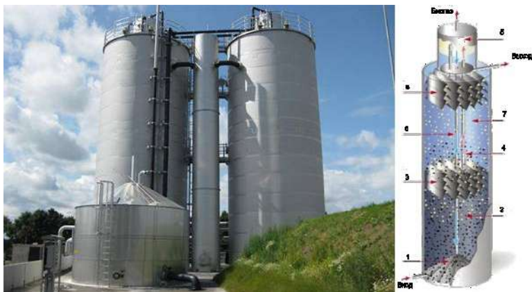
Рис. 2. Анаэробный реактор с внутренней циркуляцией 4
