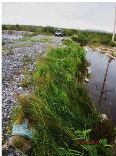
Рис. 22. Растительные блоки I типа, сформированные на прибрежной полосе и откосе дамбы. Фото Л. Ивановой
