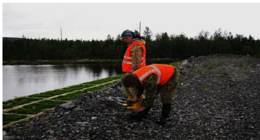
Рис. 16. Установка фитомодулей в два параллельных ряда вдоль дамбы (а) и закрепление их к берегу с помощью троса (б).
