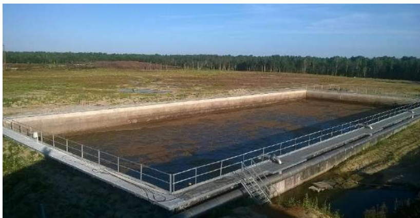
Рис. 3. Аэротенк для биологической очистки сточных вод 5
